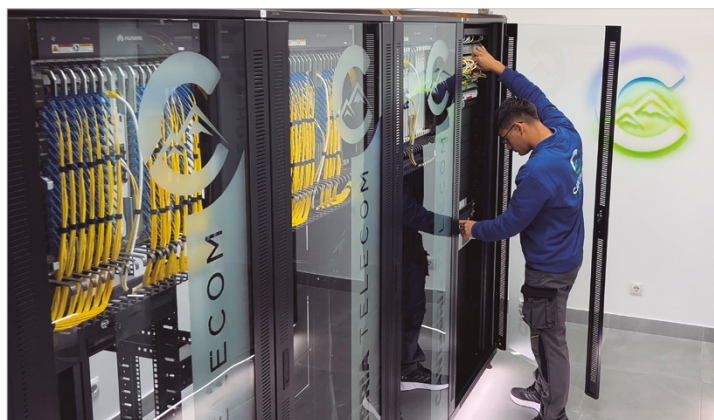
Técnico superior realizando trazado de fibra desde el centro de procesamiento de datos de Cantabria Telecom hacia los Campos de Sport de El Sardinero
